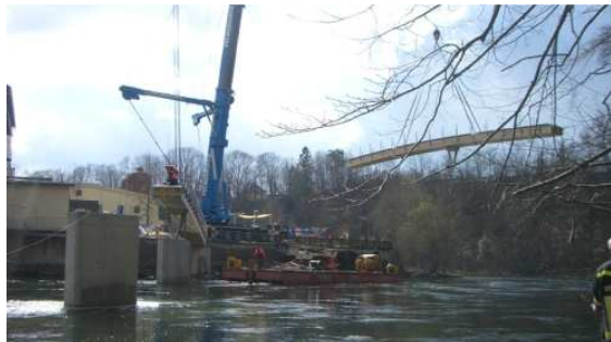
Bild 4: Montage eines Teilstücks einer Hohlkastenbrücke, das vorher im Werk weitestgehend vorgefertigt und per Schwerlastkraftwagen zum Zielort gebracht wurde.
