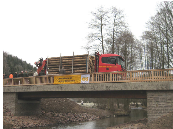
Bild 2: Pilotprojekt in Deutschland – Die Birkbergbrücke Wippra
