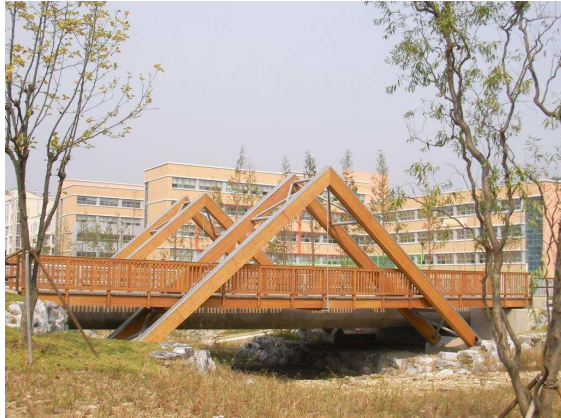
Bild 1: Ansicht von Westen
