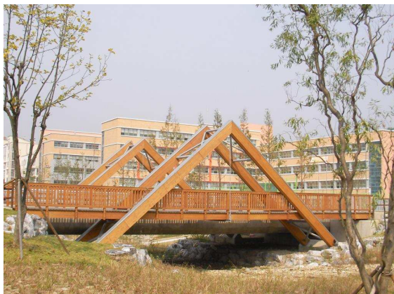
Bild 1: Ansicht von Westen
