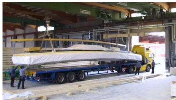
Bild 4: Transport der Deckbrücke durch einen Schwerlasttransporter. Um die Holzbrücke während der Fahrt vor Schmutz und Feuchte zu schützen, wird diese in eine widerstandsfähige Folie verpackt.
