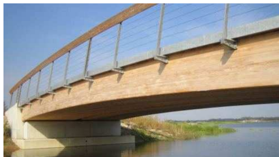
Bild 1: Ansicht auf die Schwerlastbrücke „HET RIET“: Der geschlossene Gussasphaltbelag und die überstehende Blechabdeckung bieten einen optimalen konstruktiven Holzschutz.
