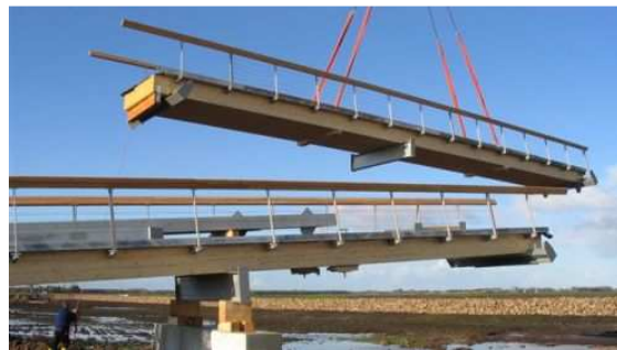
Bild 4: Montage des ersten Mittelstückes der Pylonbrücke. Die jeweiligen Einzelteile wurden im Werk so weit wie möglich vorgefertigt, um eine schnelle Montage und eine sehr gute Ausführung zu gewährleisten.
