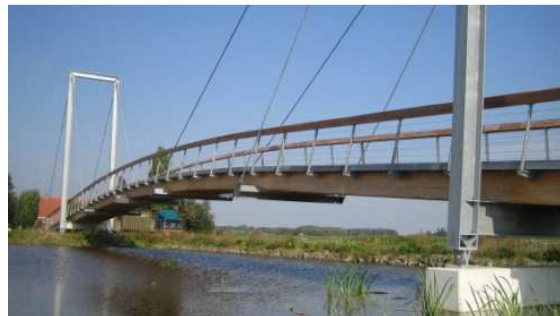
Bild 2: Die beiden Stahlpylone und die Stahlseile tragen den abgehängenen Fahrbahnbelag aus Gussasphalt.
