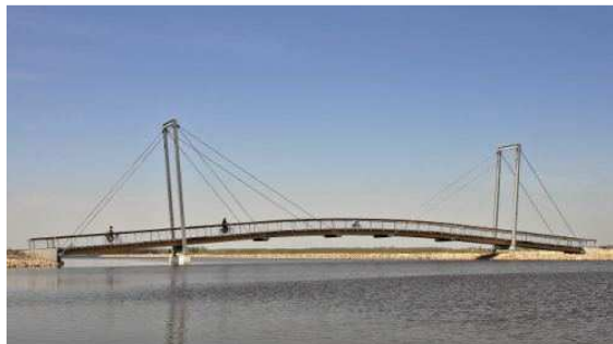
Bild 1: Ansicht auf die Pylonbrücke
