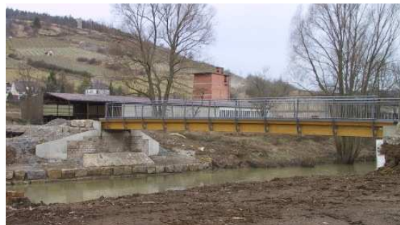
Bild 2: Seitenansicht auf die Hohlkasten kurz nach der Fertigstellung.
