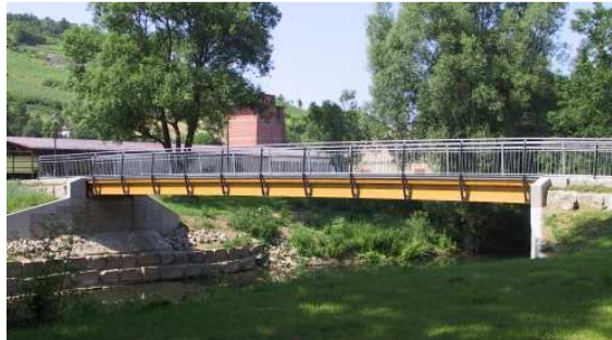
Bild 1: Ansicht auf die Hohlkastenbrücke aus blockverleimtem BSH.
