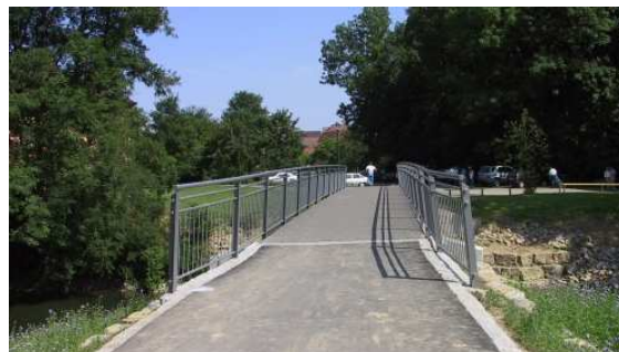
Bild 4: Vorderansicht: Im Stahlgeländer ist zusätzlich die Beleuchtung und im Hohlkasten sind Rohrleitungen integriert.
