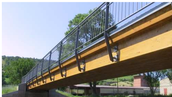
Bild 3: Durch den großen Überstand des Fahrbahnbelages aus Gussasphalt ist der Hohlkasten optimal vor der Witterung geschützt.
