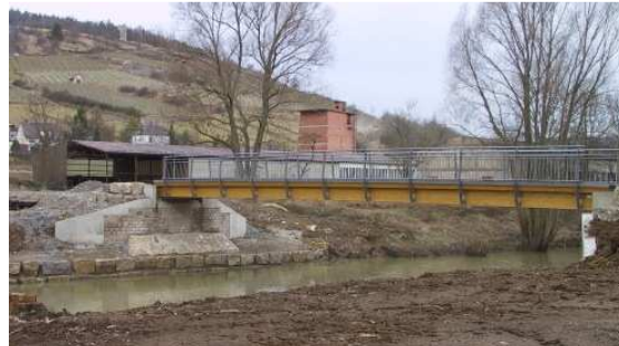
Bild 2: Seitenansicht auf die Hohlkasten kurz nach der Fertigstellung.
