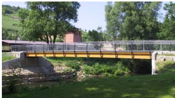
Bild 1: Ansicht auf die Hohlkastenbrücke aus blockverleimtem BSH.
