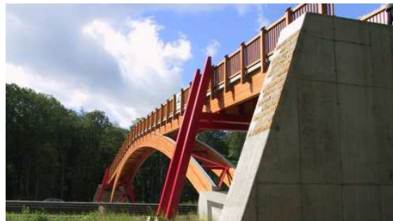
Bild 2: Der geschlossene Fahrbahnbelag aus Gussasphalt und die überstehende Zinkblechabdeckung schützen die Tragkonstruktion vor der Witterung.
