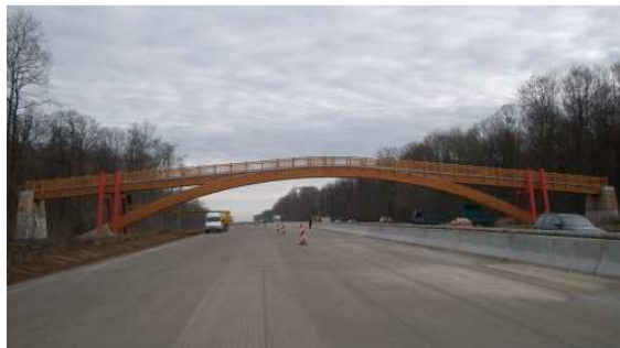
Bild 1: Die Bögen der Brücke sind aus Lärchen-BSH gefertigt.
