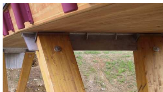
Bild 4: Detailansicht auf den Anschluss von Streben und Brückenplatte.
