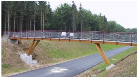
Bild 1: Ansicht auf die Sprengwerkbrücke aus BSH.
