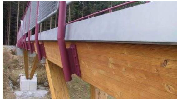
Bild 2: Der überstehende Fahrbahnbelag aus Gussasphalt bietet der blockverleimten BSH-Brückenplatte einen ausreichenden konstruktiven Holzschutz.
