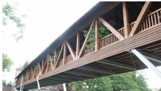
Bild 2: Ansicht auf das schützende Dach, sowie die Holzverschalung, die den Untergurt schützt. Der Rundstahldiagonalverband dient zur Aussteifung der Konstruktion.
