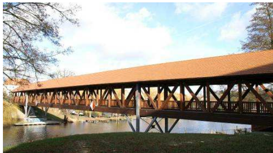
Bild 1: Ansicht auf die Fachwerkbrücke aus BSH mit Dach, welches mit Dachziegel gedeckt wurde und das Tragwerk vor der Witterung schützt.
