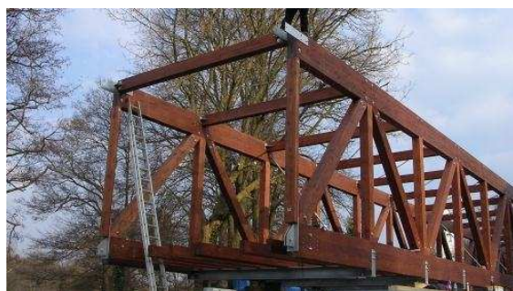
Bild 3: Ansicht auf die vorgefertigten Fachwerkträger, die auf der Baustelle zur Tragwerkskonstruktion zusammengesetzt wurden.
