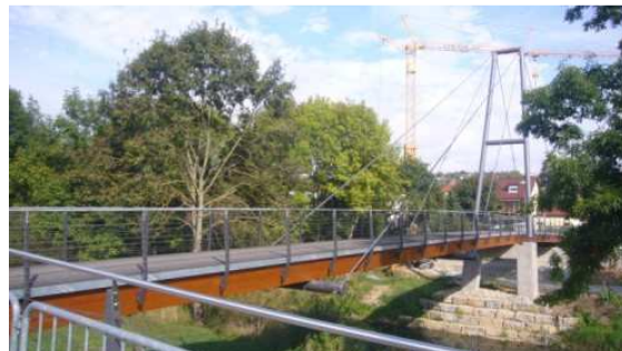
Bild 2: Der überstehende und geschlossene Fahrbahnbelag aus Gussasphalt bietet einen optimalen konstruktiven Holzschutz. Das Geländer ist aus Stahl.
