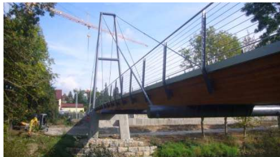
Bild 1: Ansicht auf die Pylonbrücke, dessen Holztragwerk aus blockverleimten BSH gefertigt wurde. Insgesamt besteht die Brücke aus 4 Feldern.
