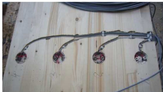
Bild 4: Um das Feuchteverhalten in blockverleimten Träger besser beurteilen zu können, wurden bei dieser Brücke Messfühler für die Holzfeuchte zwischen die Lamellen geklebt.
