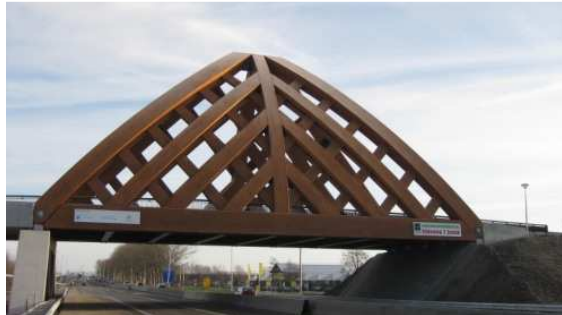
Bild 1: Ansicht auf die offene Fachwerkbrücke bei Sneek über die A7, die aus blockverleimten BSH aus acetyliertem Holz (Accoya®) gefertigt wurde.
