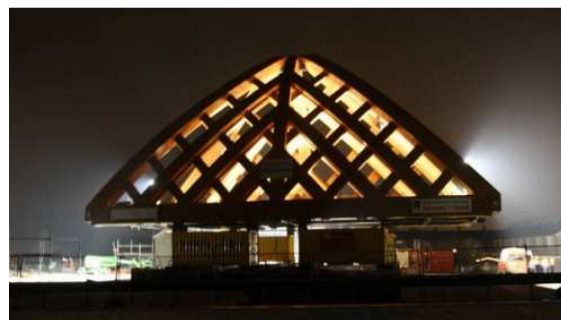
Bild 4: Die komplett zusammengesetzte Brücke wurde durch Schwerlasttransporter auf die Widerlager gefahren.
