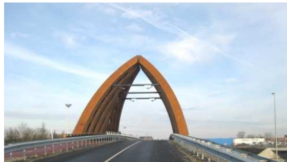
Bild 2: Seitenansicht: Die Gesamthöhe der Brücke beträgt 16 m und die Durchfahrtshöhe 4,60 m. Durch die Acetylierung ist ein weiterer Holzschutz nicht notwendig.
