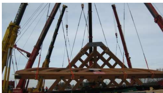
Bild 3: Die beiden Fachwerkträger wurden nahe dem Zielort zusammenmontiert. Im Bild erfolgt der Zusammenschluss der beiden Träger zum Gesamttragwerk. Dazu waren insgesamt 6 Kräne notwendig.
