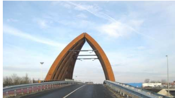
Bild 2: Seitenansicht: Die Gesamthöhe der Brücke beträgt 16 m und die Durchfahrtshöhe 4,60 m. Durch die Acetylierung ist ein weiterer Holzschutz nicht notwendig.
