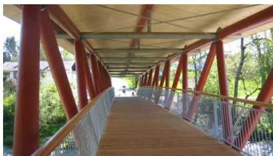
Bild 3: Der Bohlenbelag aus Holz, das Geländer und die BSH-Rundhölzer des Fachwerkes sind gut zu erkennen.
