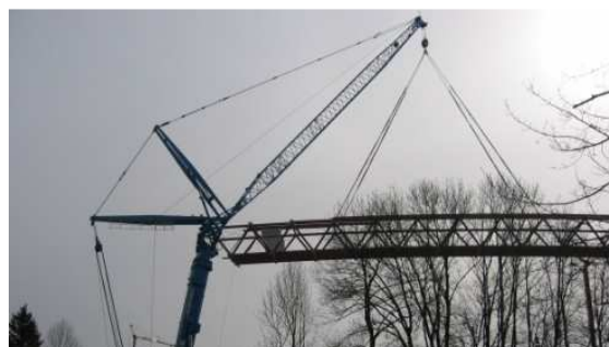
Bild 4: Montage des Fachwerkes mithilfe eines Schwerlastkranes.
