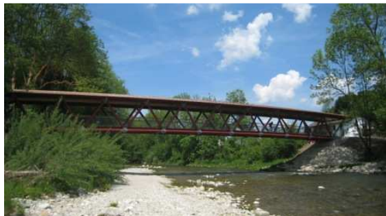
Bild 1: Ansicht auf die überdachte Fachwerkbrücke.
