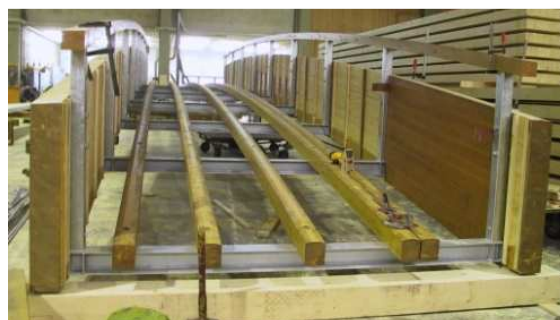
Bild 4: Vorfertigung der Trogbrücke im Werk.
