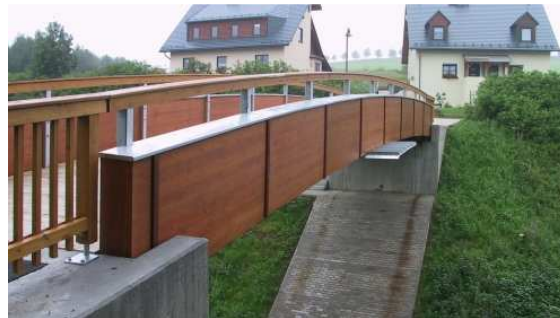
Bild 2: Seitenansicht auf die Trogbrücke. Die äußere und innere Holzverschalung aus 3-Schichtplatten, sowie die oberseitige Blechabdeckung schützen die Träger vor der Witterung.
