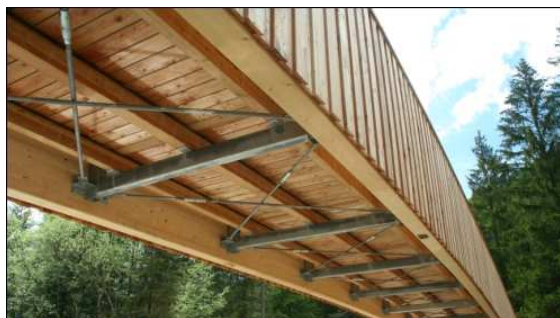
Bild 3: Unterseite der Trogbrücke. Der Stahlverbund, welcher zur Aussteifung dient, und der offene Bohlenbelag aus Lärche sind gut zu erkennen.
