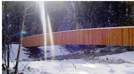
Bild 2: Seitenansicht auf die Trogbrücke. Die äußere und innere Holzverschalung aus Lärche, sowie die oberseitige Blechabdeckung aus Kupfer schützen die Träger vor der Witterung.
