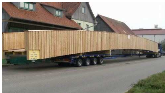
Bild 4: Transport der vorgefertigten Brücke.
