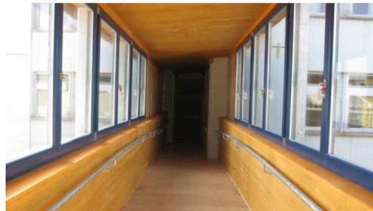
Bild 2: Innenansicht. Die Trogbrücke wird mit einem Pultdach aus Kerto-Q-Platten und Bitumenschweißbahn, sowie Fenstern abgeschlossen.
