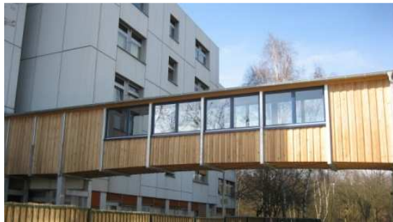
Bild 1: Seitenansicht der Verbindungsbrücke, die den Krankenhausaltbau mit dem Neubau verbindet. Von außen ist die Brücke durch eine Holzverschalung aus Douglasie vor der Witterung geschützt.
