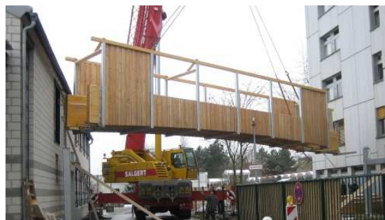
Bild 4: Montage der Trogbrücke.
