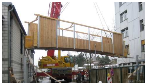
Bild 4: Montage der Trogbrücke.
