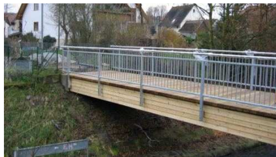
Bild 2: Die seitliche Holzverschalung bietet einen konstruktiven optimalen Holzschutz. Das Geländer ist als Stahlfüllstabgeländer ausgeführt.
