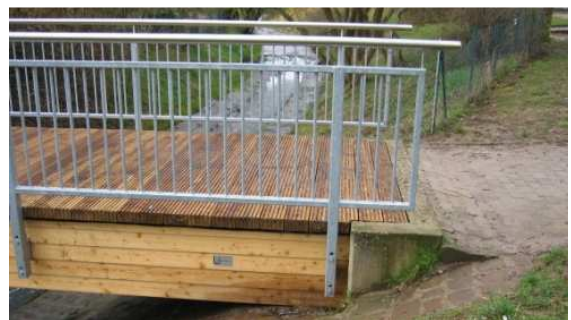
Bild 4: Ansicht auf die Widerlager und den offenen Bohlenbelag aus Lärche. Um für Rutsicherheit zu sorgen, sind die Bohlen mit gefrästen Rillen versehen.
