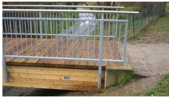
Bild 4: Ansicht auf die Widerlager und den offenen Bohlenbelag aus Lärche. Um für Rutsicherheit zu sorgen, sind die Bohlen mit gefrästen Rillen versehen.
