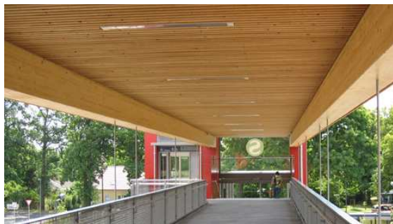
Bild 3: Abgehängene Decke mit integrierten Versorgungsleitungen
