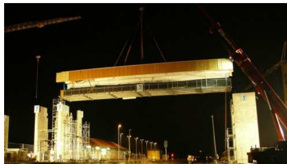
Bild 4: Montage bei Nacht zwischen den kurzen Sperrzeiten
