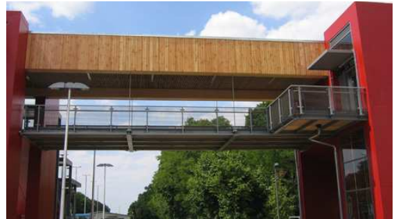
Bild 2: Ansicht Mittelteil mit Holzverschalung
