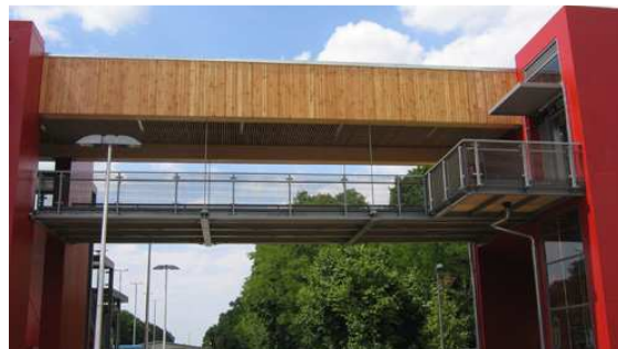
Bild 2: Ansicht Mittelteil mit Holzverschalung
