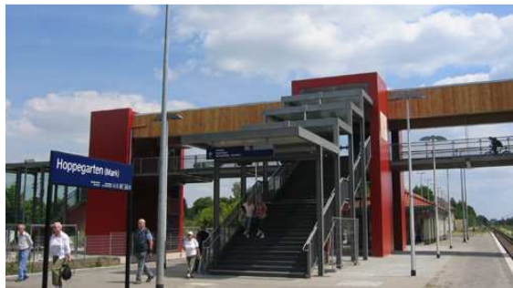
Bild 1: Ansicht Aufgang und linker Teil mit abgehängener Stahlfahrbahn
