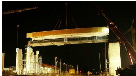
Bild 4: Montage bei Nacht zwischen den kurzen Sperrzeiten
