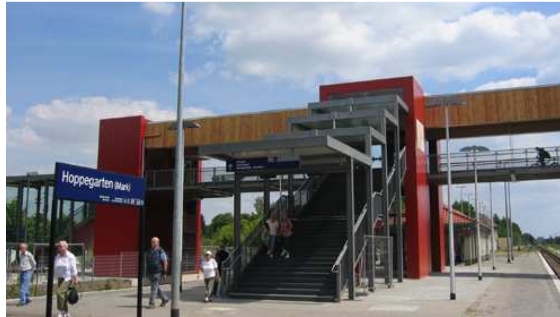
Bild 1: Ansicht Aufgang und linker Teil mit abgehängener Stahlfahrbahn
