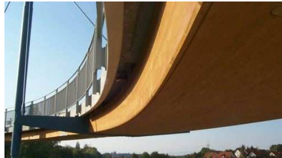
Bild 2: Ansicht auf die Unterseite. Die Blechabdeckung und der geschlossene Fahrbelag aus Betonfertigteilen schützen den blockverleimten Träger vor der Witterung. Gut zu erkennen ist der Abstand zwischen Fahrbelag und Träger, der für eine gute Hinterlüftung sorgt, und so Staunässe verhindert.
