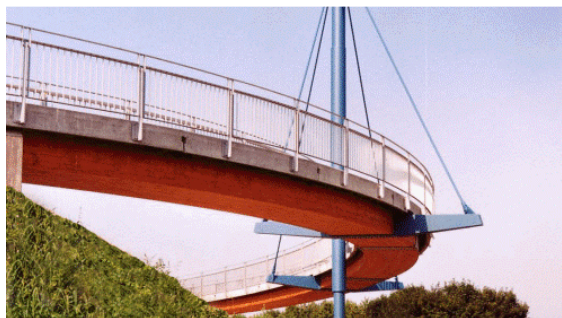
Bild 3: Seitenansicht: Geländer, blockverleimter BSH-Träger und blauer Pylon sind gut zu erkennen.
