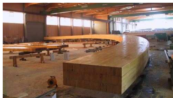
Bild 4: Ansicht auf den fertig verleimten, gefrästen und lackierten Träger im Werk.
