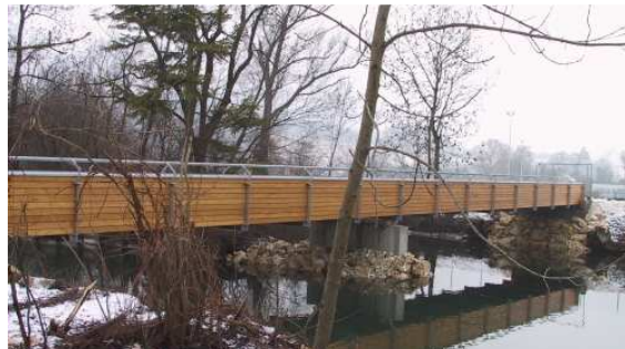
Bild 1: Seitenansicht der Trogbrücke, dessen Träger aus BSH gefertigt wurden.
