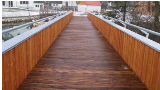
Bild 2: Ansicht auf den offenen Bohlenbelag, der durch die Fräsung rutschsicher ist.
