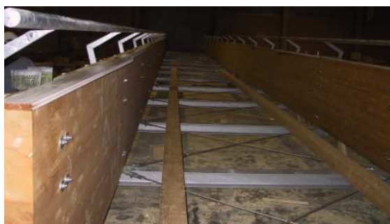
Bild 4: Ansicht auf die Brücke während der Vorfertigung im Werk. Der Stahlverbund zur Aussteifung ist gut zu erkennen.
