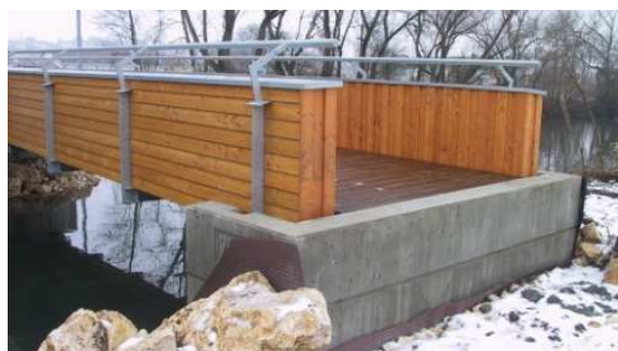
Bild 3: Die oberseitige Blechabdeckung aus Titanzink sowie die Holzverschalung aus Douglasie auf der Innen- und Außenseite schützen die Träger, die sich in Geländerebene befinden, vor der Witterung.
