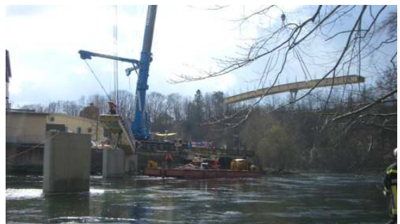
Bild 4: Montage des zweiten Teilstückes. Dieses wird mit Hilfe eines Krans an die richtige Position gesetzt und über Stahlbleche und Passbolzen miteinander verbunden.
