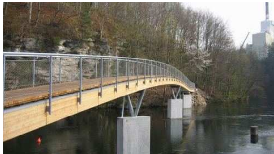
Bild 1: Die Blockträgerbrücke erreicht durch die Zwischenlager eine Gesamtspannweite von 80 m.
