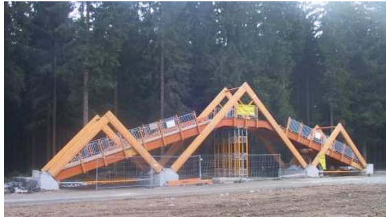
Bild 1: Ansicht auf die Sprengwerkbrücke aus BSH, die für den Skilanglauf im Winter konzipiert wurde.
