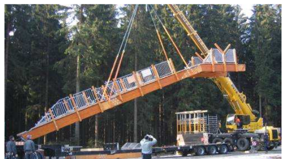
Bild 4: Montage des linken Brückenteils mithilfe eines Schwerlastkranes.
