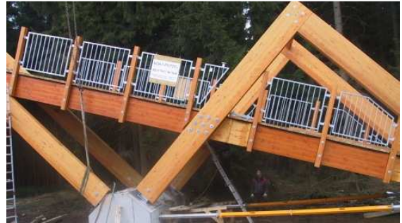
Bild 2: Detailansicht auf den rechten Brückenteil. Gut zu erkennen ist, dass die BSH-Träger durch Lärchen-Dreischichtplatten vor der Witterung geschützt werden.
