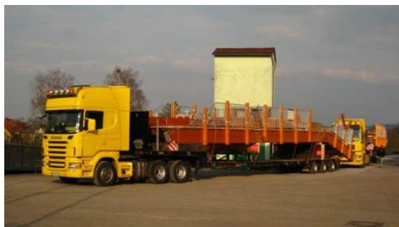
Bild 3: Der Transport der Fahrbahnkonstruktion erfolgte durch 2 Schwerlasttransporter. Der Fahrbahnbelag wurde als offener Bohlenbelag und das Geländer als Holzgeländer mit Stahlfüllung ausgeführt.
