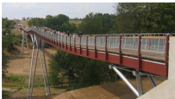
Bild 3: Durch eine seitliche Holzverkleidung und das überstehende Aluminiumblech zwischen Bohlenbelag und BSH-Spannband ist das Haupttragwerk konstruktiv gut geschützt.
