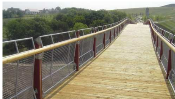
Bild 2: Bohlenbelag, Handlauf und Geländerpfosten sind aus Lärche. Die Geländerfüllung ist ein Rundrohr mit Punktschweißgitter.
