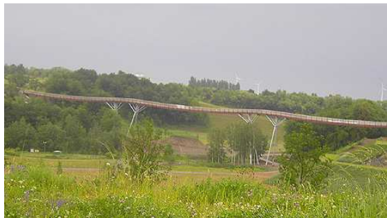
Bild 1: Seitenansicht auf die Spannbandbrücke, die das Gessental der Neuen Landschaft Ronneburg überspannt
