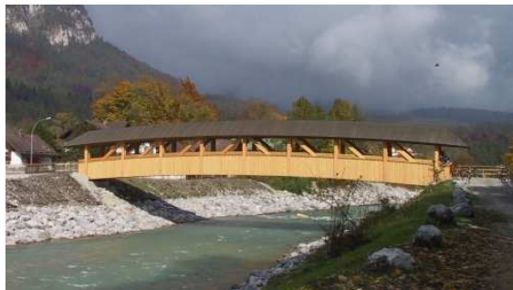
Bild 1: Ansicht auf die Fachwerkbrücke aus BSH mit Dach, welches mit Kupferblech gedeckt wurde und das Tragwerk vor der Witterung schützt.
