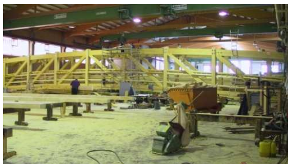
Bild 3: Ansicht auf die Vorfertigung des Fachwerkträgers im Werk.
