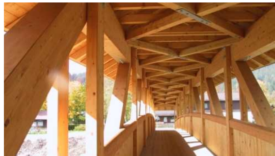
Bild 2: Innenansicht: Das Holzgeländer, der Bohlenbelag, sowie der hölzerne Aussteifungsverband sind gut zu erkennen.
