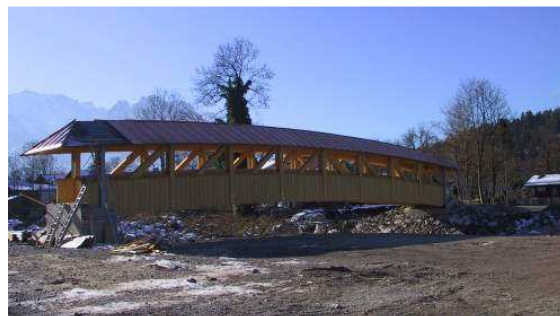
Bild 4: Ansicht auf die Fachwerkbrücke kurz nach der Montage.
