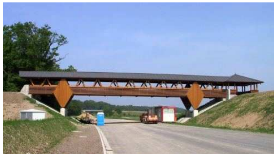
Bild 1: Ansicht auf die überdachte Fachwerkbrücke aus blockverleimtem Douglasien-BSH, an dessen rechten Brückenkopf ein Pavillon angeschlossen ist.
