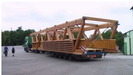
Bild 3: Transport des Fachwerkträgers, der im Werk vorfertigt wurde. Auch der Bohlenbelag ist schon vorhanden.
