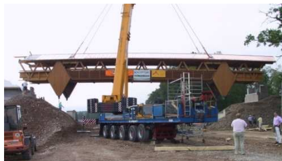
Bild 4: Montage der Fachwerkbrücke, die vorher auf der Baustelle aus den vorgefertigten Bauteilen aus dem Werk zusammengesetzt wurde.
