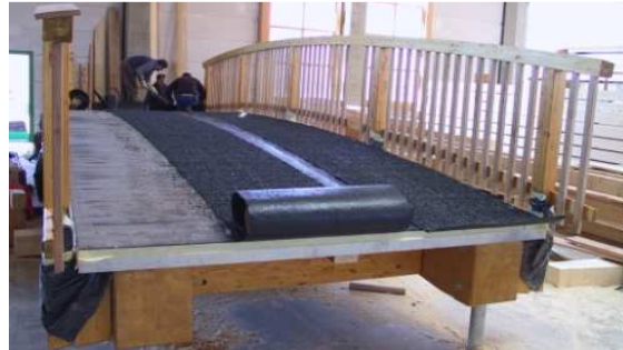
Bild 2: Der Belag von der Rolle bildet eine geschlossene Fahrbahn und einen optimalen konstruktiven Holzschutz.
