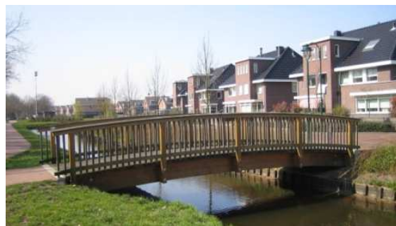
Bild 4: Die Deckbrücke befindet sich auch drei Jahre nach der Erbauung in einem guten Zustand.
