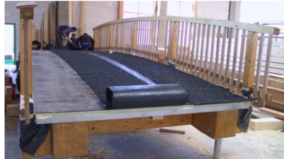
Bild 2: Der Belag von der Rolle bildet eine geschlossene Fahrbahn und einen optimalen konstruktiven Holzschutz.
