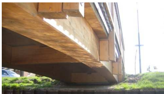
Bild 3: Ansicht auf die Unterseite. Die Queraussteifung wurde bei dieser Deckbrücke ebenfalls aus BSH gefertigt.
