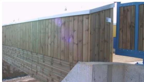
Bild 4: Seitenansicht auf die äußere Holzver-schalung
