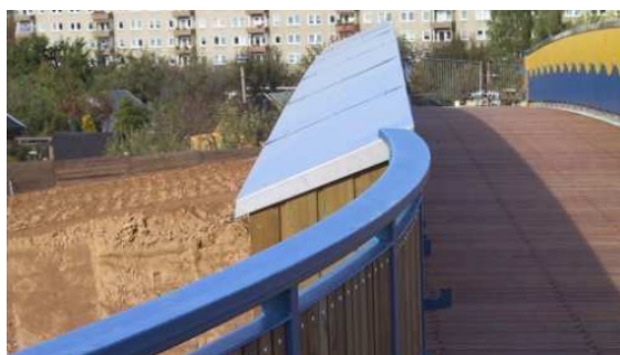
Bild 3: Die oberseitige Blechabdeckung schützt die Träger aus BSH, die sich in Geländerebene befinden, vor der Witterung.
