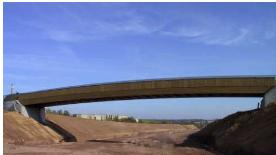
Bild 1: Seitenansicht der Trogbrücke in Chemnitz.
