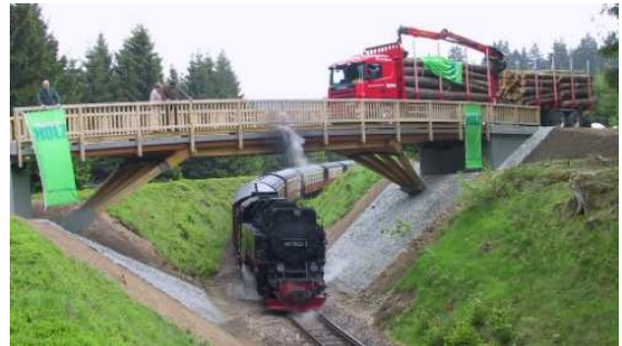
Bild 2: Der überstehende Fahrbahnbelag aus Gussasphalt schützt die Längsträger aus blockverleimten Lärchen-BSH.
