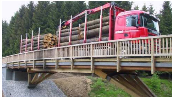
Bild 1: Ansicht auf die Sprengwerkbrücke
