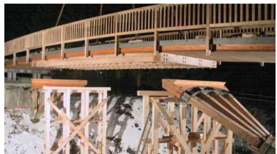
Bild 4: Montage: Der blockverleimte Holzträger wird auf die beiden Streben des Sprengwerkes gesetzt.
