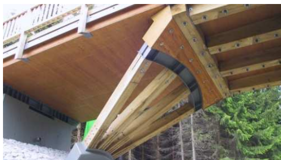
Bild 3: Das Sprengwerk selbst wurde aus Eichenvollholz gefertigt. Das Geländer ist ebenfalls aus Eiche.
