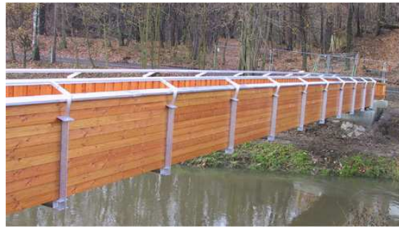
Bild 4: Seitenansicht auf die verkleideten BSH-Träger.
