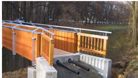
Bild 2: Frontansicht mit Lehrrohrführung.
