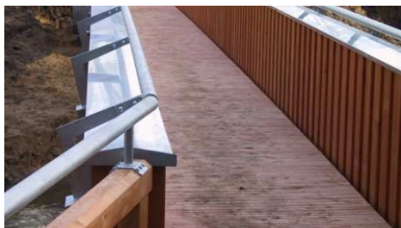
Bild 3: Die oberseitige Blechabdeckung, sowie die seitliche Holzverschalung aus Douglasie schützen die Träger aus BSH, die sich in Geländerebene befinden.
