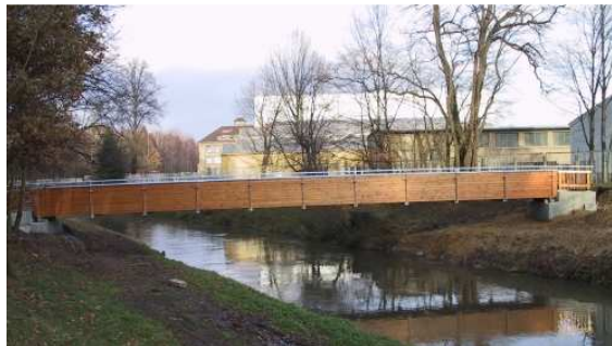
Bild 1: Seitenansicht der Trogbrücke über die Spree
