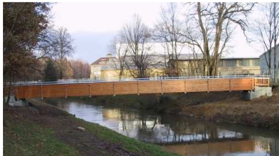
Bild 1: Seitenansicht der Trogbrücke über die Spree
