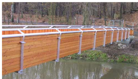
Bild 4: Seitenansicht auf die verkleideten BSH-Träger.
