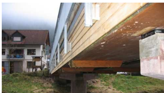
Bild 3: Ansicht auf die Unterseite. Die hinterlüftete Holzverschalung und die BSH-Träger sind gut zu erkennen.
