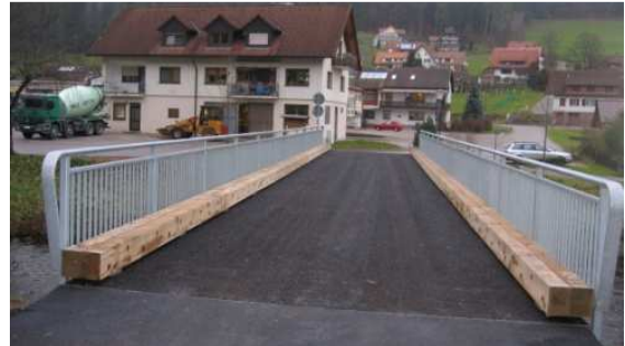
Bild 2: Um die Lebensdauer des Schrammbords zu verlängern, sind diese mit Abstand zum Fahrbanbelag angebracht, so dass sich keine Staunässe bilden kann. Auch die beiden Vollholzkantbretter sind mit Abstand zueinander verbunden.
