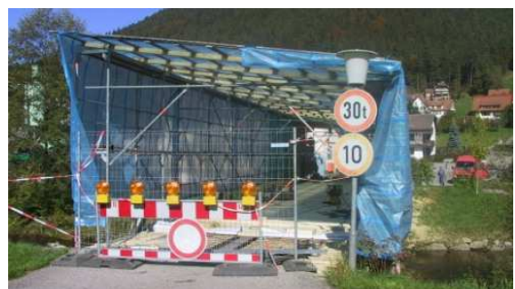
Bild 4: Zustand während der Bauarbeiten.
