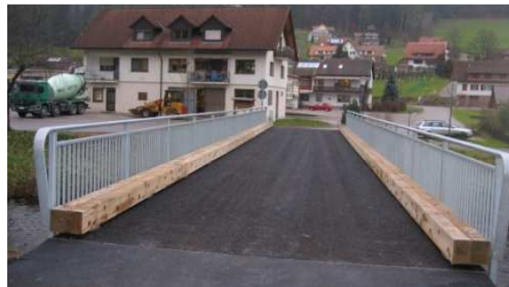
Bild 2: Um die Lebensdauer des Schrammbords zu verlängern, sind diese mit Abstand zum Fahrbanbelag angebracht, so dass sich keine Staunässe bilden kann. Auch die beiden Vollholzkantbretter sind mit Abstand zueinander verbunden.
