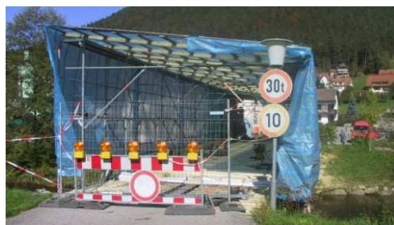
Bild 4: Zustand während der Bauarbeiten.
