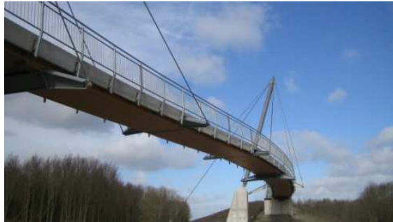
Bild 1: Ansicht auf die S-förmige Pylonbrücke aus blockverleimten BSH. Sie besteht insgesamt aus 7 Felder.
