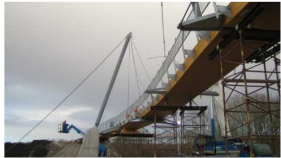
Bild 4: Ansicht während der Montage. Die Pylone, das Geländer, sowie die Abhängung sind aus Stahl.
