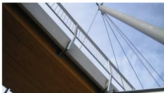
Bild 3: Ansicht auf die Unterseite, sowie den Pylon rechts.
