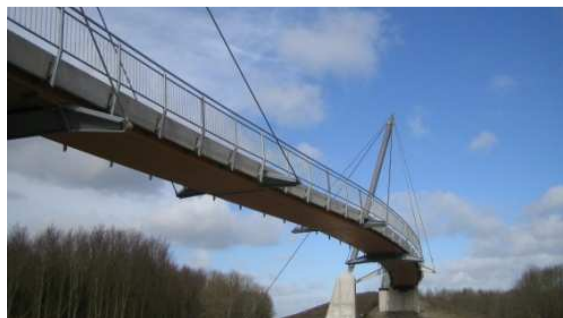
Bild 1: Ansicht auf die S-förmige Pylonbrücke aus blockverleimten BSH. Sie besteht insgesamt aus 7 Felder.
