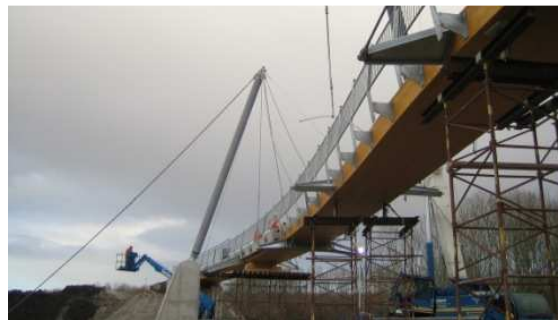
Bild 4: Ansicht während der Montage. Die Pylone, das Geländer, sowie die Abhängung sind aus Stahl.
