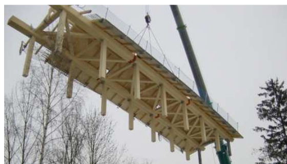
Bild 4: Montage des Fachwerkdaches mithilfe eines Schwerlastkranes. Aufgrund der großen Spannweite wurde das Dach in drei Einzelteilen montiert.
