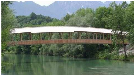
Bild 1: Ansicht auf die Fachwerkbrücke aus blockverleimtem BSH mit Dach, das mit Lärchenschindeln gedeckt ist.
