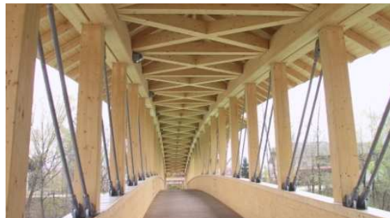
Bild 2: Innenansicht der Fachwerkbrücke. Das überstehende Dach bietet dem Tragwerk optimalen Schutz gegenüber der Witterung.
