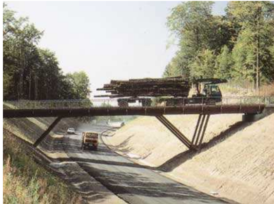
Bild 1: Ansicht auf die Sprengwerkbrücke mit LKW.
