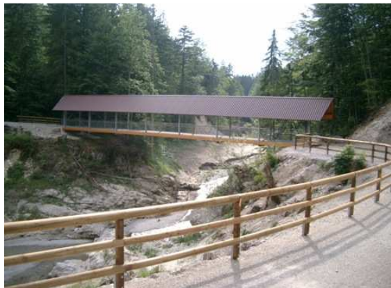
Bild 1: Ansicht auf die Fachwerkbrücke aus BSH mit Dach, welches dem Ober- und Untergurt durch seinen Überstand ausreichenden Witterungsschutz bietet.
