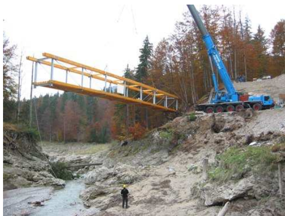
Bild 3: Montage des vorgefertigten Fachwerkträgers, der als Holz-Stahl-Konstruktion ausgeführt wurde.
