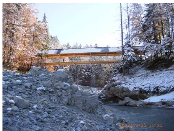
Bild 4: Seitenansicht auf die Fachwerkbrücke im Winter.
