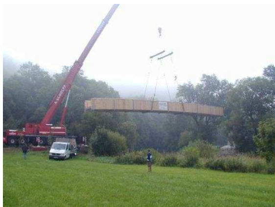
Bild 3: Montage der vorgefertigten Trogbrücke im Werk mithilfe eines Schwerlastkranes.
