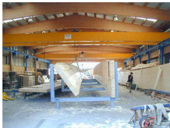
Bild 4: Vorderansicht während der Vorfertigung der Trogbrücke im Werk.
