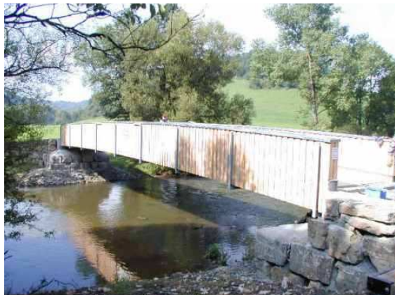
Bild 1: Ansicht auf die Trogbrücke aus BSH.
