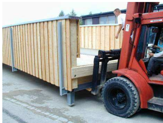
Bild 2: Vorderansicht bei der Verladung. Der Bohlenbelag ist auch schon vorhanden.
