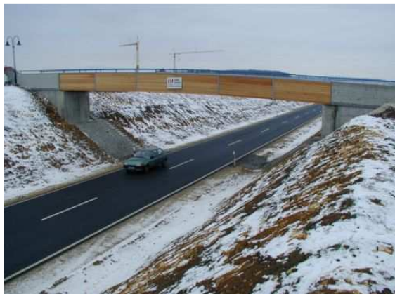
Bild 1: Ansicht auf die Trogbrücke aus BSH.
