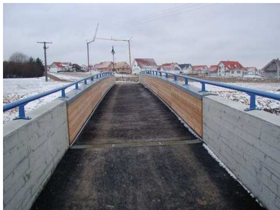
Bild 3: Der Fahrbahnbelag wurde als geschlossener Gussasphaltbelag ausgeführt.
