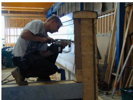
Bild 4: Vorderansicht während der Fertigung im Werk. Der konstruktive Holzschutz wird durch die beidseitige abgeschrägte, oberseitige Blechabdeckung, sowie der inneren und äußeren Holzverschalung gewährleistet.
