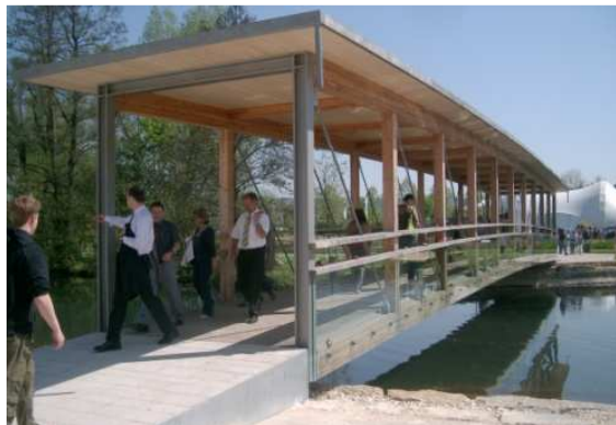
Bild 1: Ansicht auf die Fachwerkbrücke aus BSH mit Dach.
