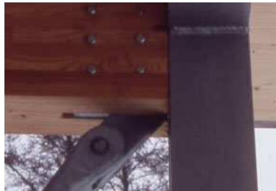
Bild 2: Detailansicht auf Anschluss Obergurt, Stahlrahmen und Stahldiagonale.
