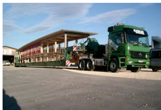
Bild 4: Transport der im Werk so weit wie möglich vorgefertigten Fachwerkbrücke mit einem Schwerlasttransporter.
