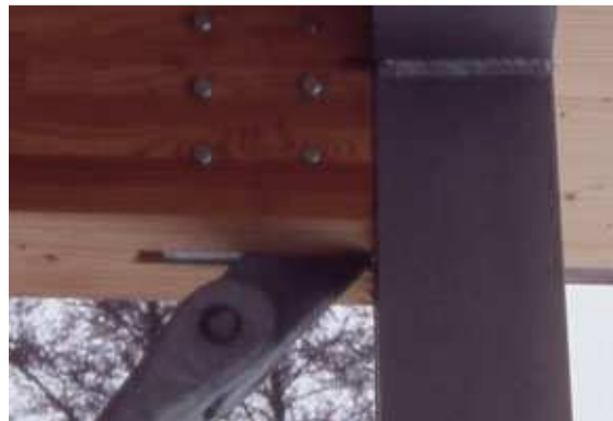
Bild 2: Detailansicht auf Anschluss Obergurt, Stahlrahmen und Stahldiagonale.
