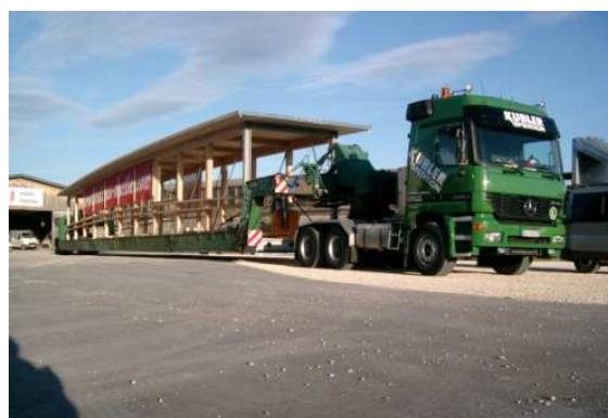
Bild 4: Transport der im Werk so weit wie möglich vorgefertigten Fachwerkbrücke mit einem Schwerlasttransporter.
