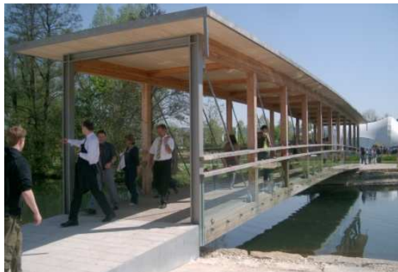
Bild 1: Ansicht auf die Fachwerkbrücke aus BSH mit Dach.
