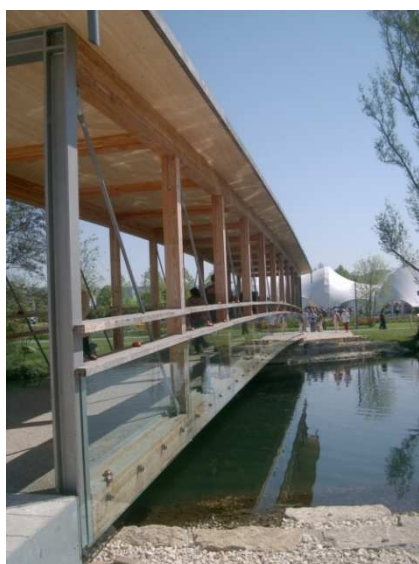
Bild 3: Seitenansicht: Der Obergurt ist durch das überstehende Dach und der Untergurt durch eine Isolierglasverkleidung, welche als Geländer dient, vor der Witterung konstruktiv optimal geschützt. Der Fahrbahnbelag wurde als 2-lagiger Gussasphalt ausgeführt.
