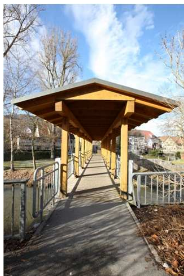
Bild 3: Frontansicht: Der ausreichende Dachüberstand bietet dem Holztragwerk und offenem Bohlenbelag einen optimalen konstruktiven Holzschutz.
