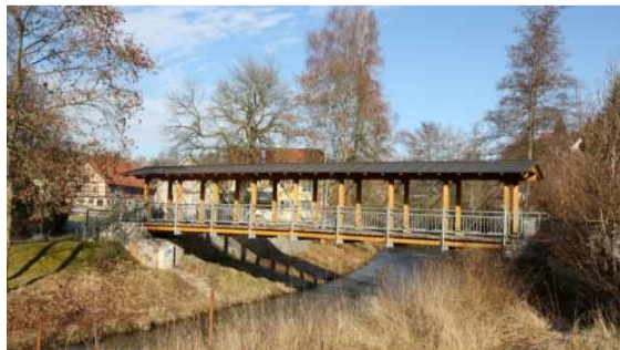
Bild 1: Ansicht auf die Fachwerkbrücke aus BSH mit einem Dach aus Kupferblech.
