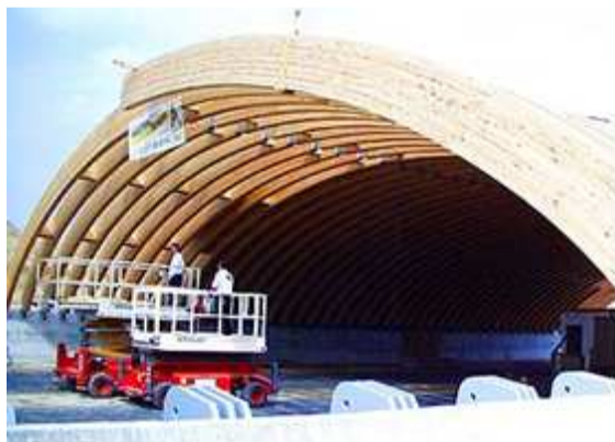
Bild 3: Montage der Bogenbinder
