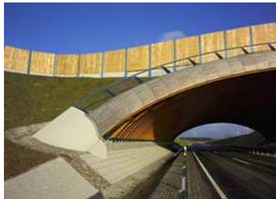
Bild 4: Auflagerpunkt Portalträger
