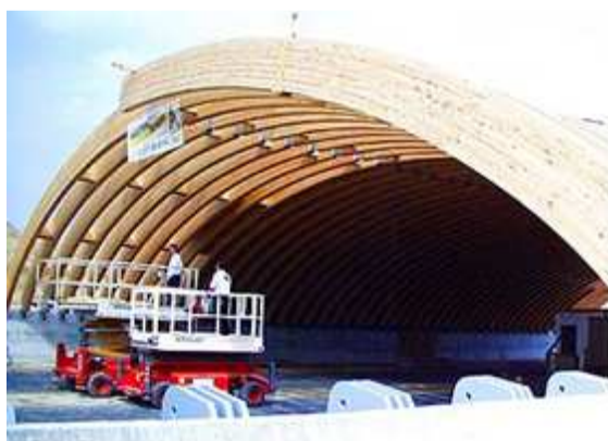
Bild 3: Montage der Bogenbinder
