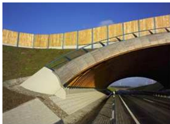
Bild 4: Auflagerpunkt Portalträger
