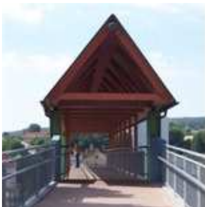
Bild 3: Ansicht von Norden
