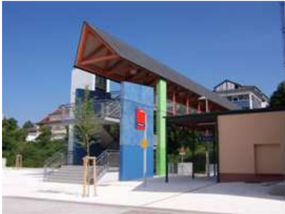
Bild 1: Ansicht von Süden
