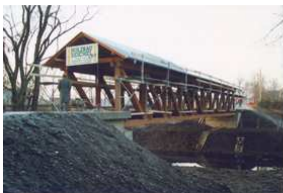
Bild 3: Ansicht von Norden (Bauphase)
