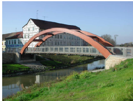
Bild 2: Ansicht Unterstrom (Südwest)
