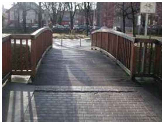
Bild 3: Blick auf den Überbau
