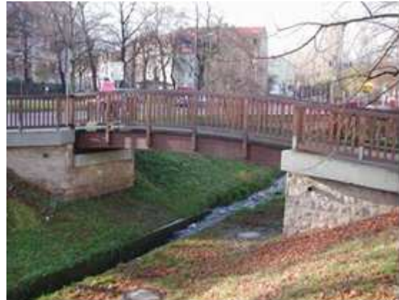
Bild 2: Ansicht von Unterstrom
