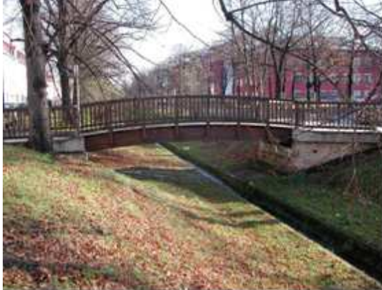
Bild 1: Ansicht von Oberstrom
