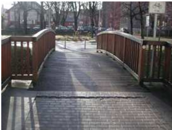
Bild 3: Blick auf den Überbau
