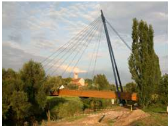
Bild 1: Ansicht von Unterstrom (Südseite)
