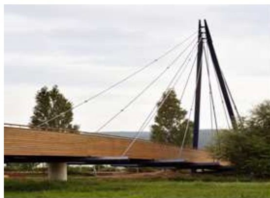
Bild 4: Ansicht von Unterstrom (Nordseite)
