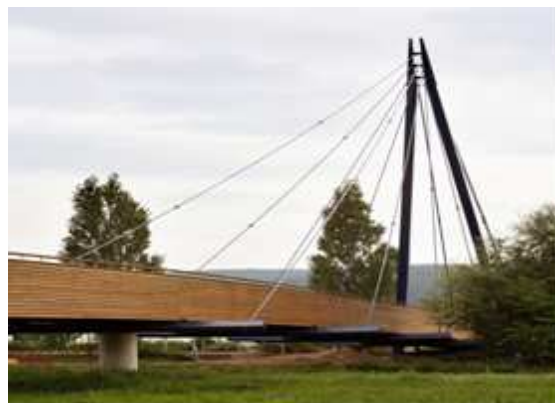
Bild 4: Ansicht von Unterstrom (Nordseite)
