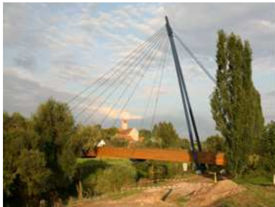
Bild 1: Ansicht von Unterstrom (Südseite)
