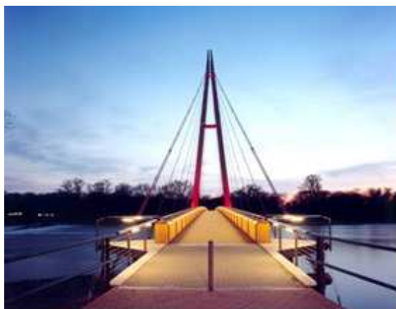
Bild 3: Ansicht von Osten
