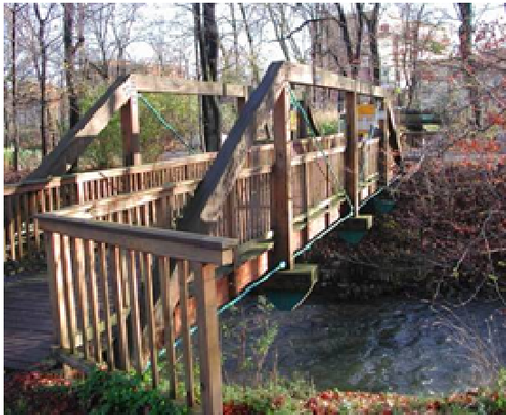
Bild 1: Ansicht Widerlager West
