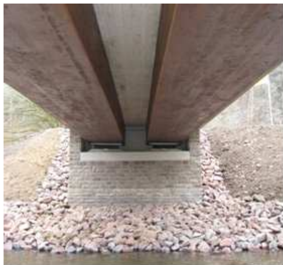
Bild 3: Ansicht von unten
