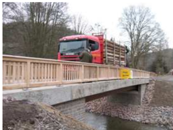
Bild 2: Ansicht von Oberstrom
