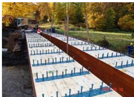
Bild 4: Einheben der vorgefertigten BSH-Blockträger
