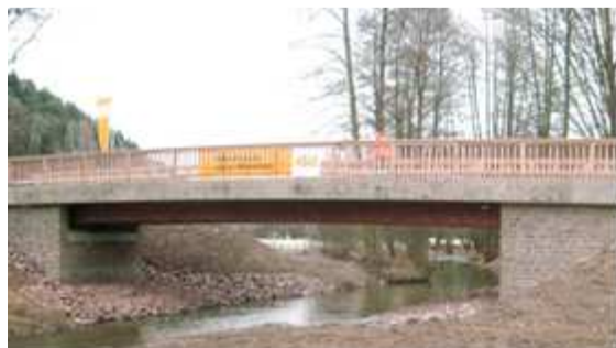
Bild 1: Ansicht von Oberstrom
