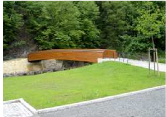
Bild 2: Ansicht von der Straße
