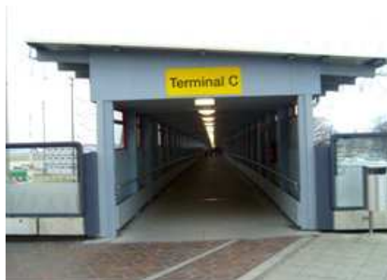
Bild 4: Ansicht vom Hauptterminal aus
