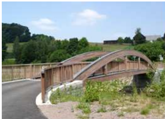
Bild 1: Ansicht von Westen
