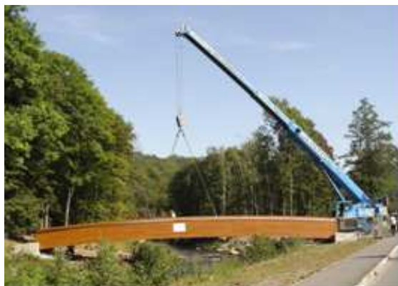
Bild 3: Einhub der vorgefertigten Brücke
