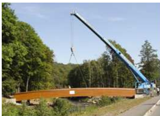
Bild 3: Einhub der vorgefertigten Brücke
